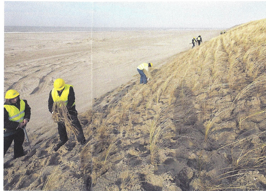
De aanleg van Maasvlakte 2 vordert met rasischreden. Een deel van de nieuwe 'zachte zeewering' wordt al beplant met helmgras.
